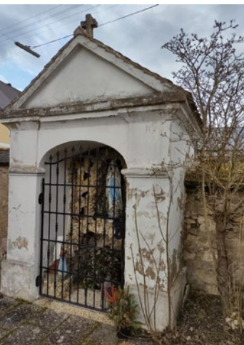
Zustand der Grotte vorher
